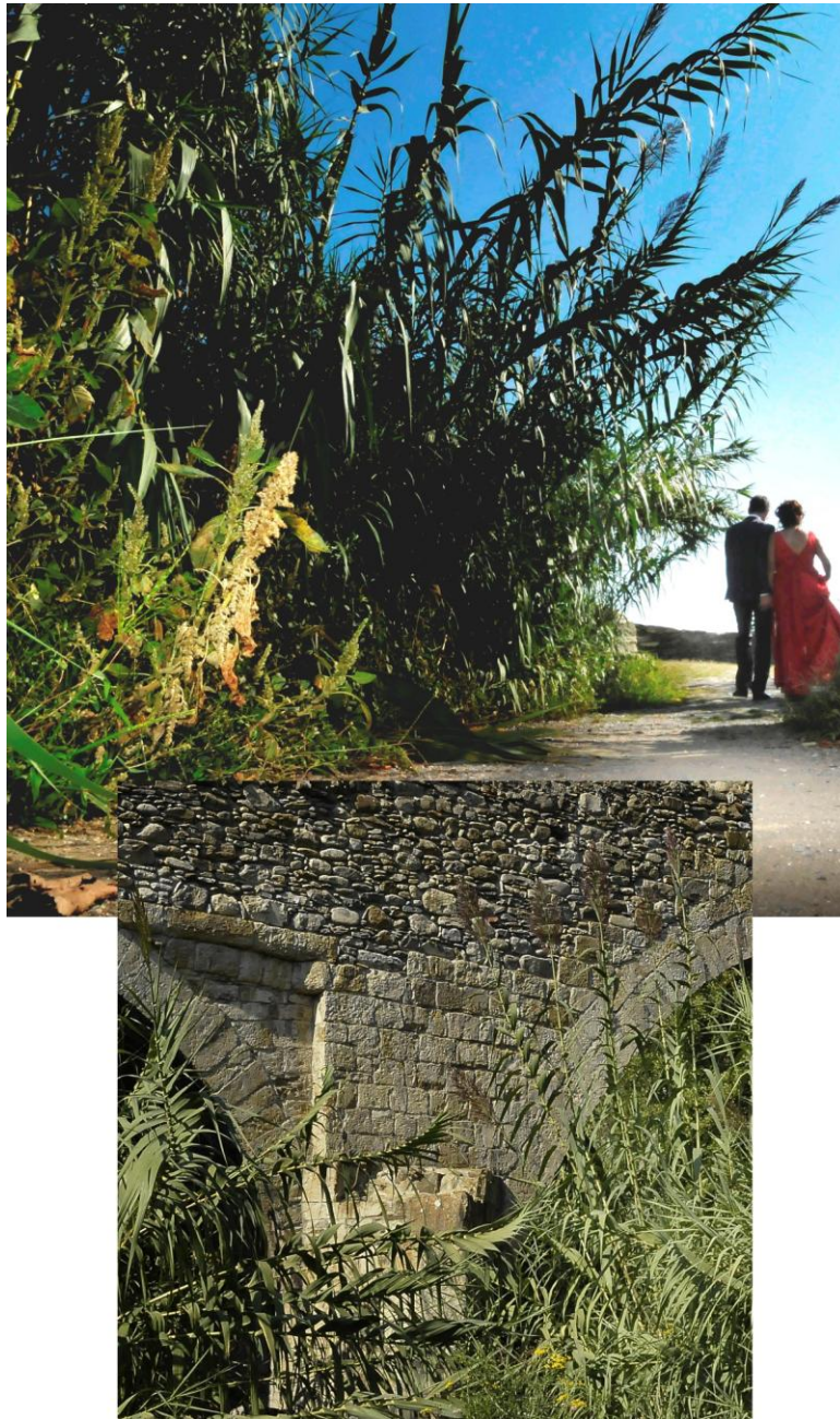
Sopra: Imperia, Frazione Torrazza; Accesso al ponte medievale di Clavi - In basso: Particolare strutturale del ponte di Clavi a Torrazza, sec. XIII (Foto An&An dal sito regionale "Cultura in Liguria")
